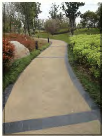
海绵城市建设——雨水收集利用设施、透水路面
