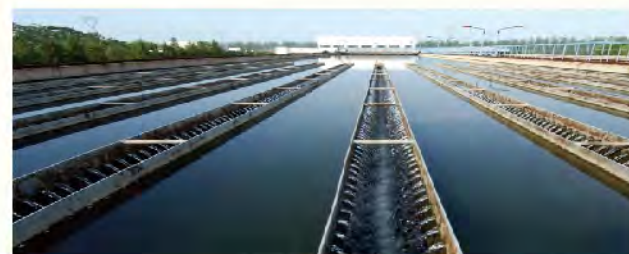
沉淀池的出水
